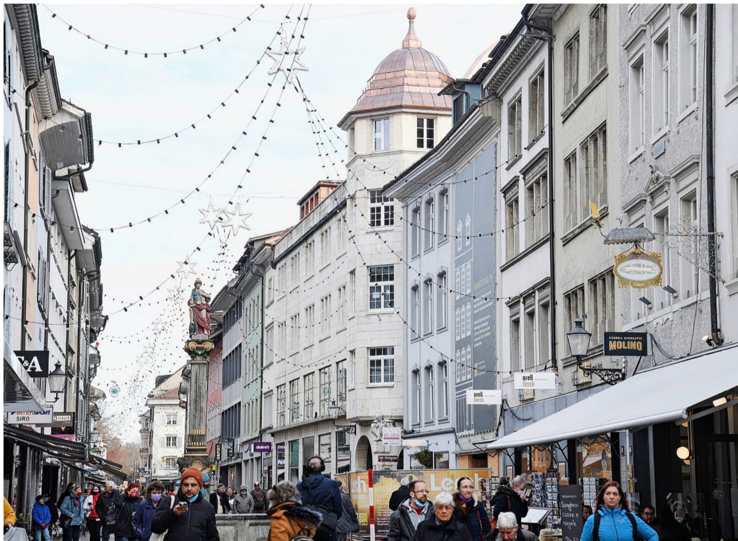
Das Baugerüst um das im Jahr 1907 erbaute Rothaus mit seinem Eckerker ist verschwunden. Auf das Möbelhaus Pfister folgt ein 24-Stunden-Lokal. Foto: Madeleine Schoder
