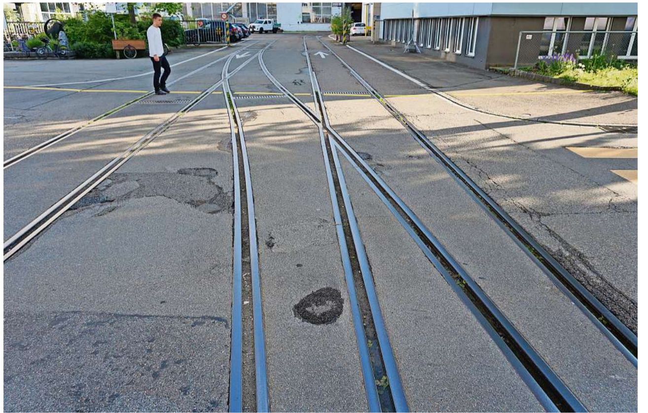
Die Gleise, die über die Klosterstrasse führen, sind seit Jahren ungenutzt.
