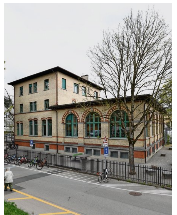
Nach langem Brodeln knallte es: Das Schulhaus Brühlberg. Madeleine Schoder
