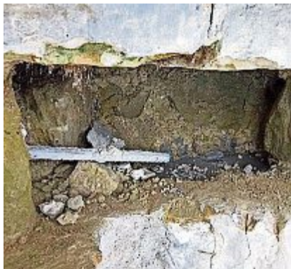
Mit Edelstahlrohren und Mörtel wird das äussere wieder mit dem inneren Mauerwerk verbunden.
