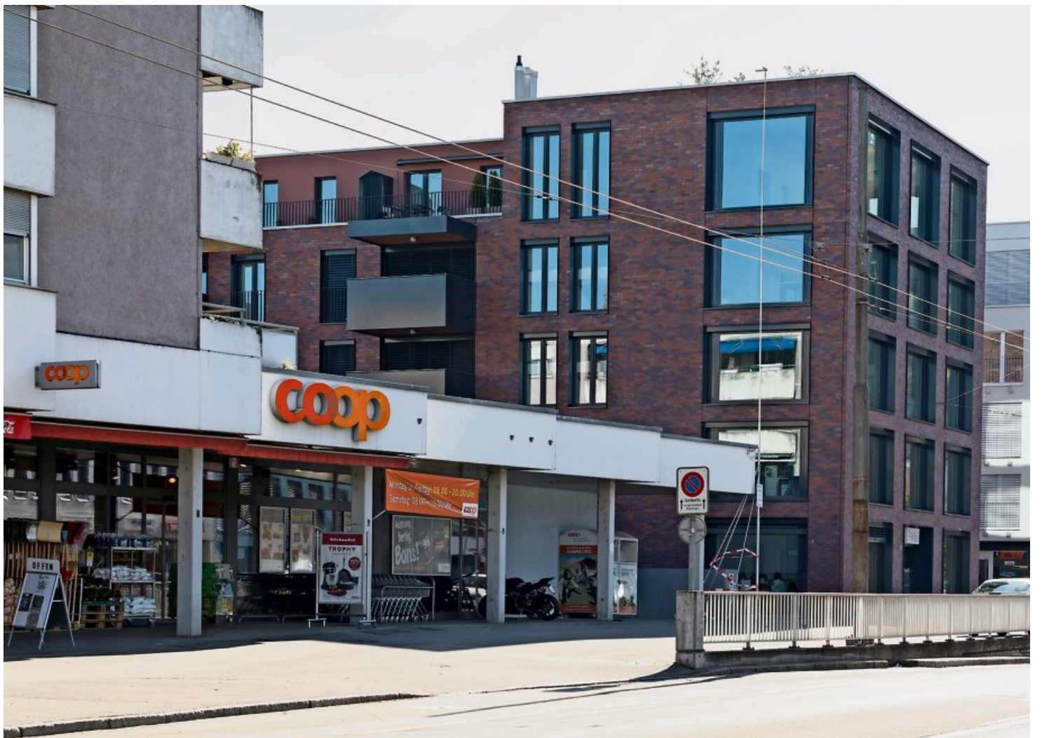
Der Coop muss weg, doch der geplante Neubau war derart ungenügend geplant, dass die Bauinspektion intervenierte.
