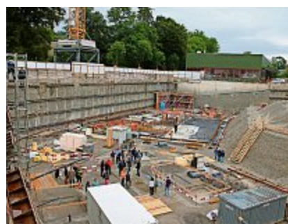
Die Baugrube zeigt die Dimension des entstehenden Polizeigebäudes auf.
